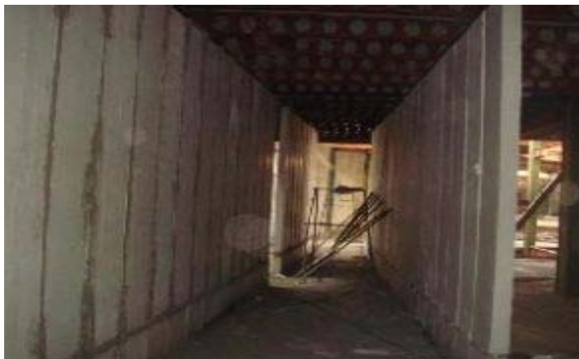
شکل (۲-۲۲). نمایشی از اجرای دیوارهای 3D در ساختمان سازی
