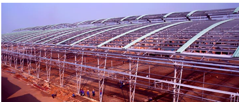
شکل (۲-۲). سیستم قاب مفصلی و خرپا
