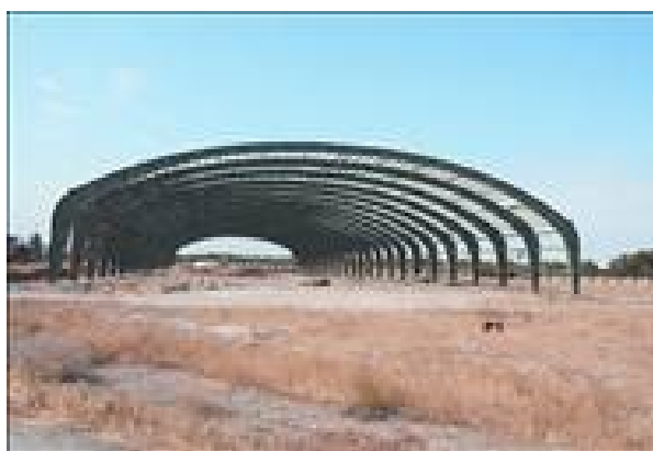
شکل (۲-۶). سیستم قابهای صنعتی با مقطع متغیر
