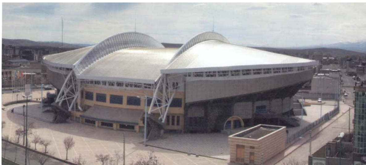
شکل (۲-۲۰). نمایی از پوشش سقف به وسیله زیپ تچ در ورزشگاهی در اردبیل
