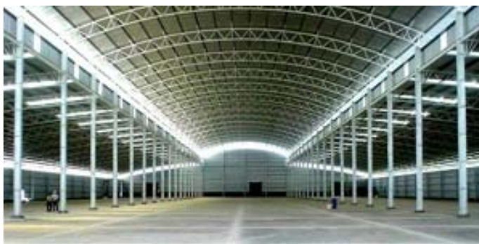
شکل (۱-۲). سیستم قاب مفصلی و خرپا
