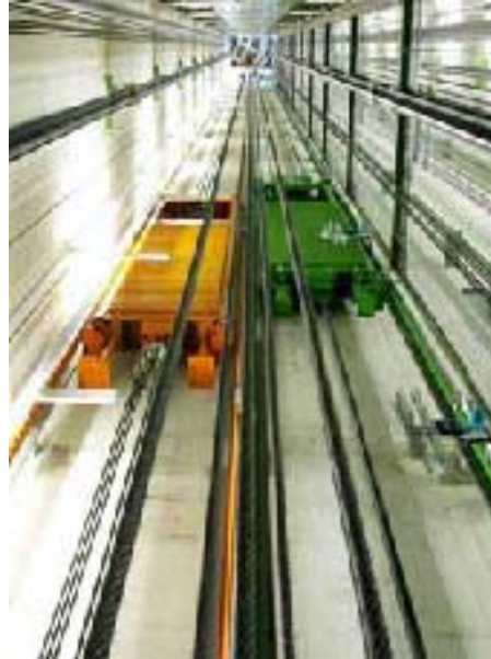
۹- تصویر سیستم آسانسور هوشمند با دو کابین در یک چاله و تجهیزات مربوطه
